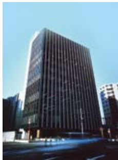
(株)ロッテの本社ビル
