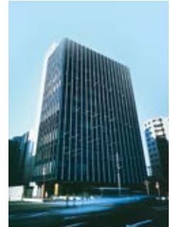
(株)ロッテの本社ビル
