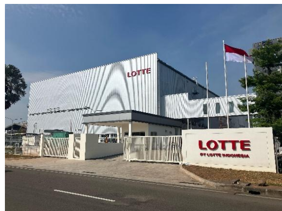
ロッテインドネシア ブカシ工場新工場の外観
