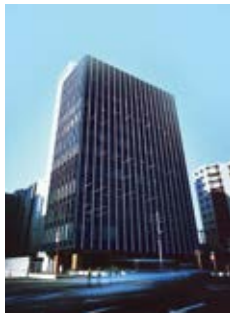
(株)ロッテの本社ビル
